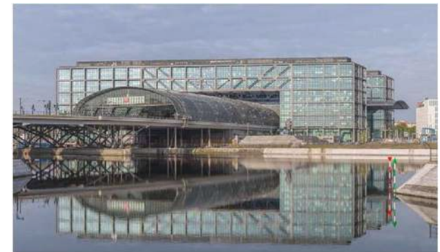
Κεντρικός Σταθμός Τρένου, Βερολίνο
